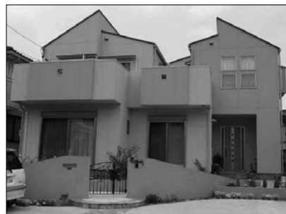
株欧倫ホーム 施工
