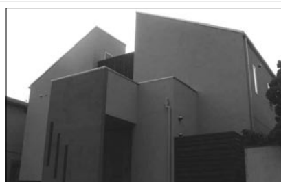
株三和木 施工
