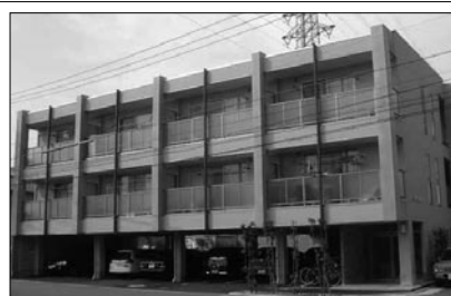
株欧倫ホーム 施工
